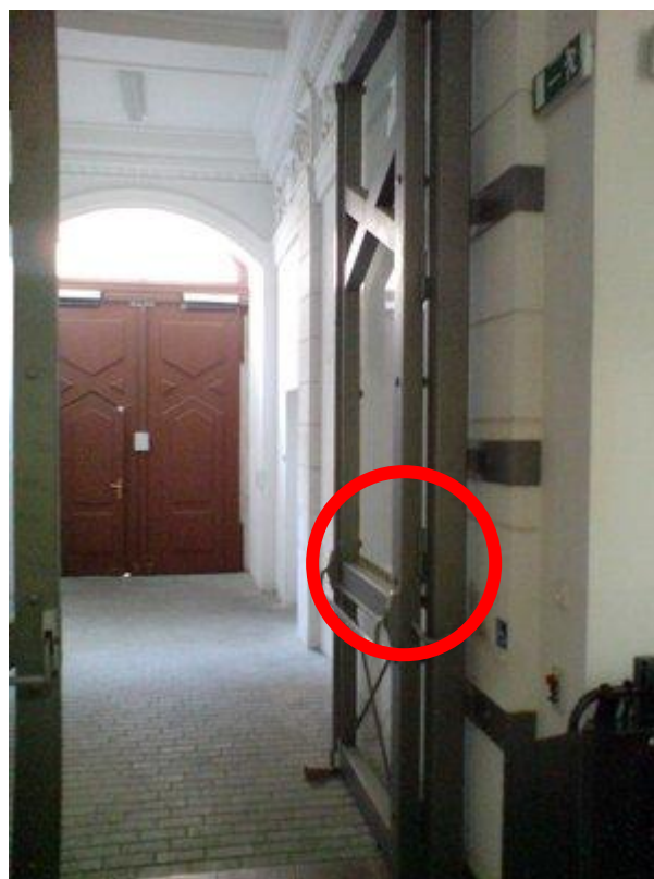
Foto04 – stávající čtečka karet přístup.systému
